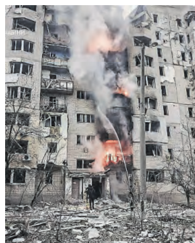
Edifício residencial atingido
