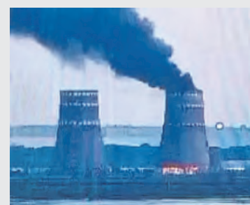
Torre de refrigeração ardeu
